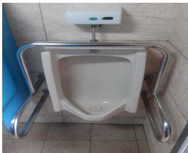
教學大樓廁所
