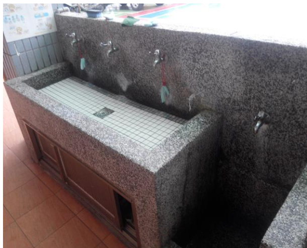
行政大樓洗手台
