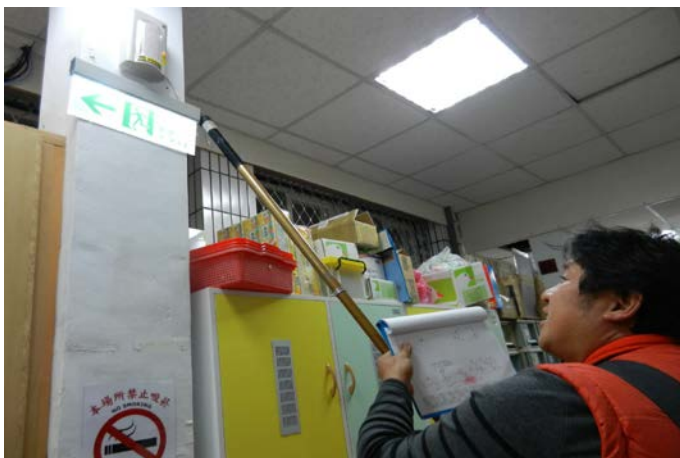
緊急照明燈檢查
