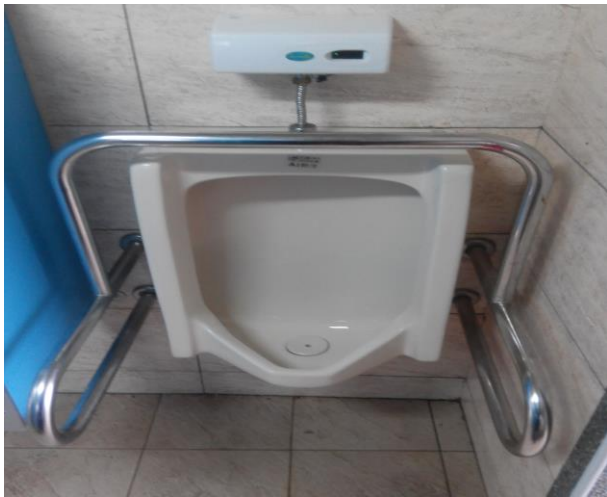
教學大樓廁所
