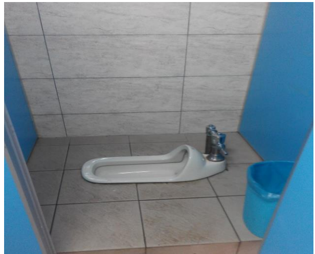
教學大樓廁所
