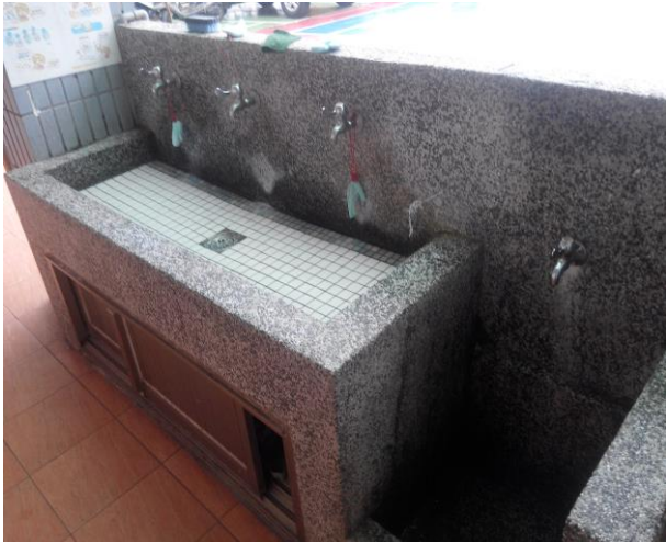
行政大樓洗手台
